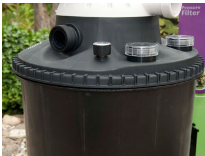
Eén kant zal aansluiten, de ander nog niet
